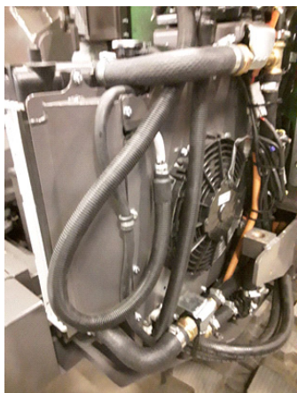
Figur 6.42 Radiator på baksiden
